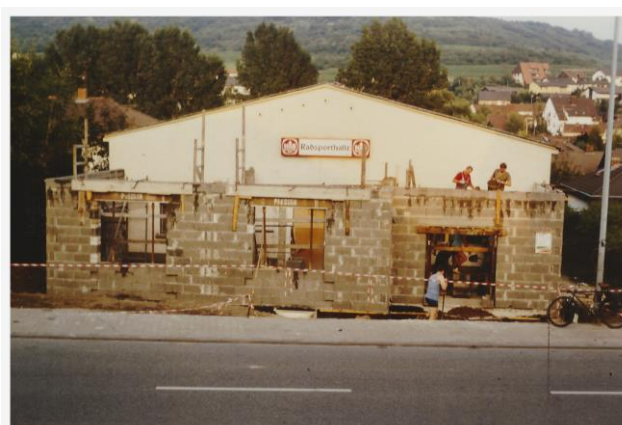
Das Erdgeschoss wird gemauert
