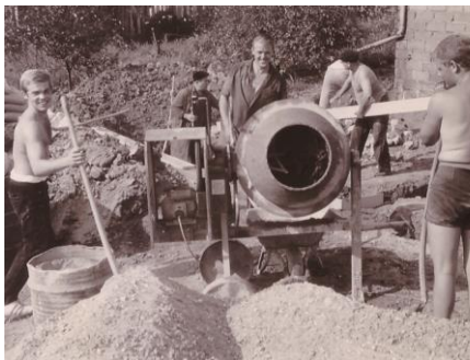
Die Radballjugend an der Betonmaschine
