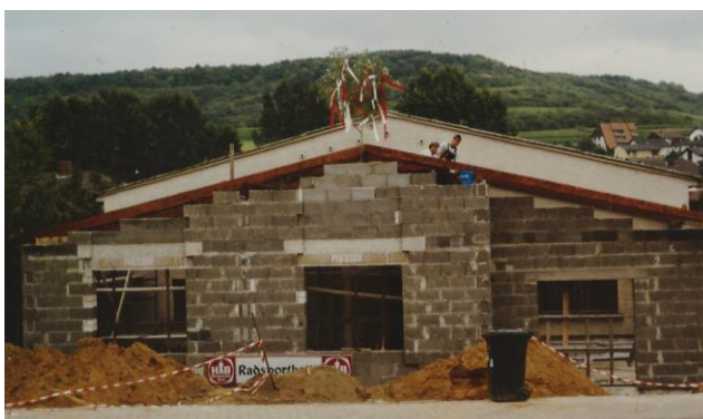
Die Kellerdecke vom Anbau ist gegossen
