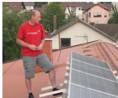
Der 1. Vorsitzende (2005-2015) Hermann Schön begutachtet die installierten PV-Module auf dem Dach der Radsporthalle
