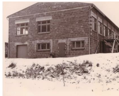
Nach nur 7 Monaten Bauzeit steht der Rohbau
