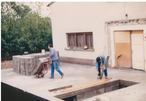
Die Kellerdecke vom Anbau ist gegossen
