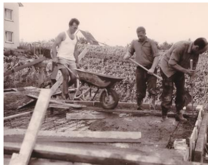
Die Decke wird gegossen
