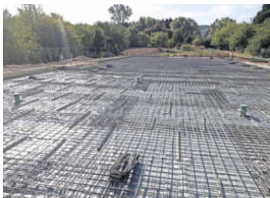
Bodenplatte und erste Aufbauten
