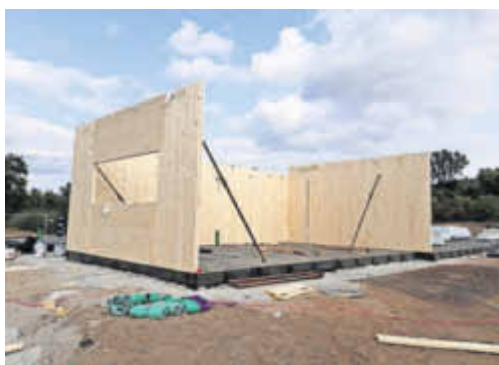
Bodenplatte und erste Aufbauten
