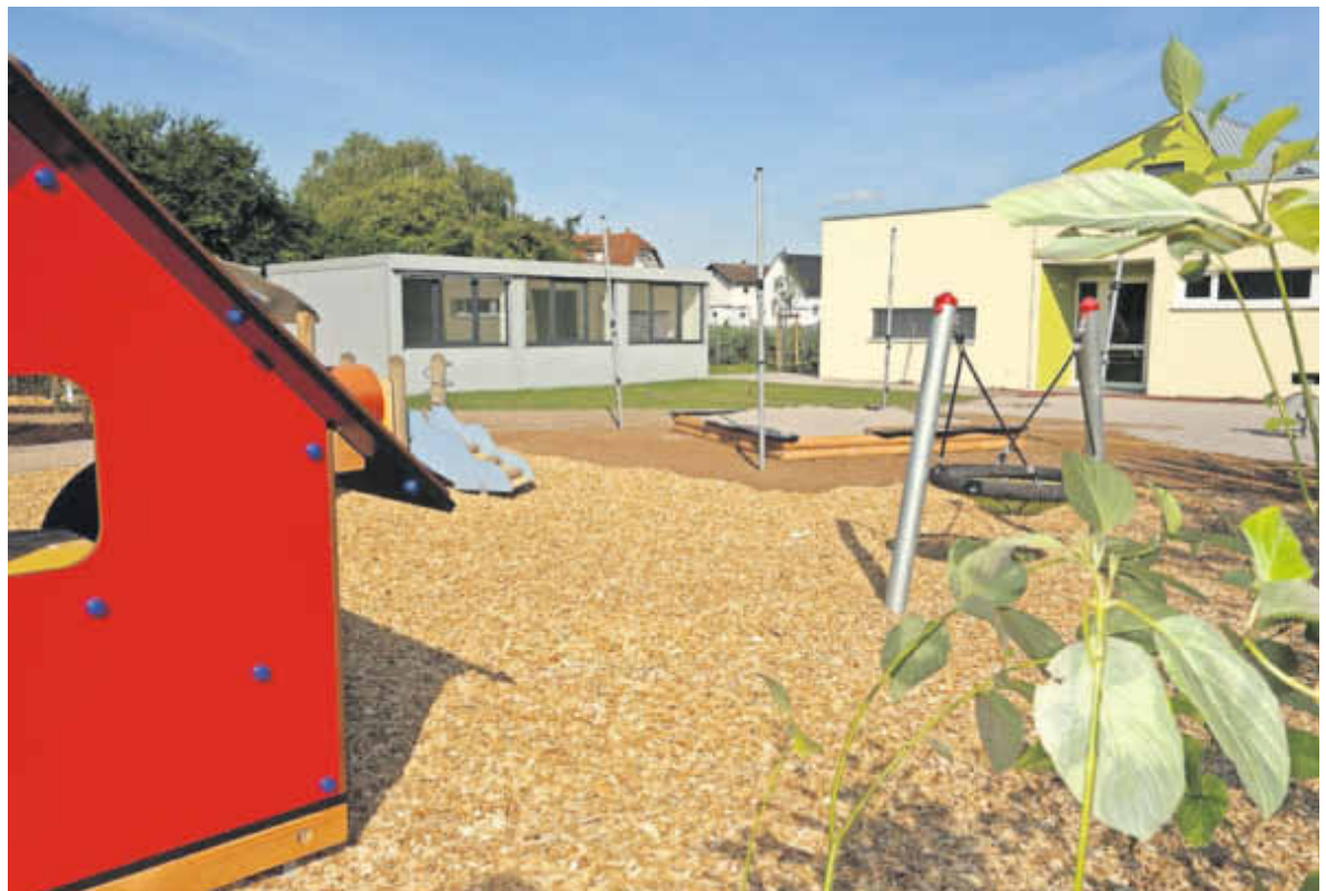
Außenanlage vor der Fertigstellung
