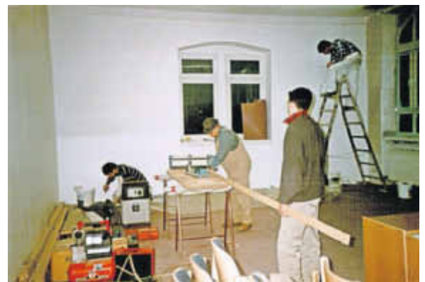
Fotos vom Um- und Ausbau
