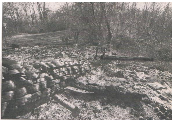
Nur noch Aschereste sind von der Aussichtshütte „Gaga“ auf der Richardshöhe übrig geblieben. Ein Feuer, das von niemand bemerkt wurde, hat die massive Holzkonstruktion völlig zerstört. Stadtbürgermeister Hassemer hofft auf einen Wiederaufbau. Bild: Thomas Schmidt
