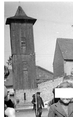
Feuerwehrhaus 1954 vor dem Umbau
