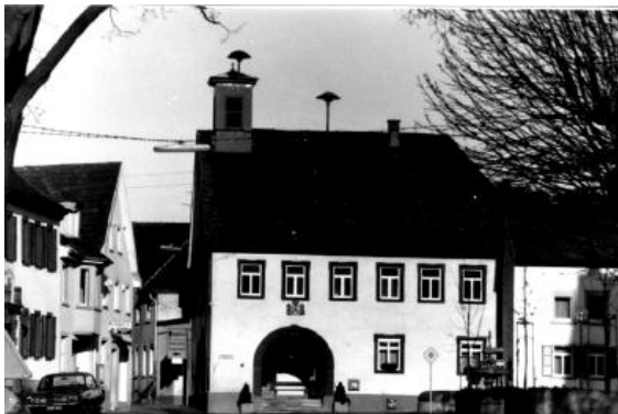
Abb. 14: Im Schwabenheimer Rathaus war von 1742 - 1944 das Gemeindebackhaus untergebracht
