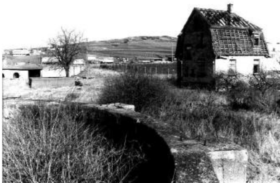
Abb.3: Das ehemalige Gasmeisterhaus vor dem Abriss im Jahre 1979
