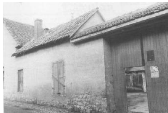
Abb. 9: Eingang zu Bullenstall und Eichenstall in der Ingelheimer Straße 4
