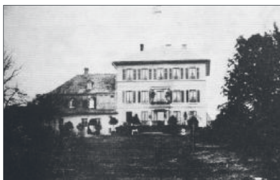
Abb. 9 a Villa Erlanger etwa 1860 (Die niedrige Hälfte ist vermutlich ein Rest des ehemaligen Jesuitenhofes)
