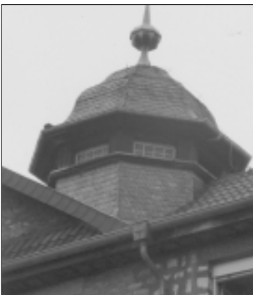
Dachreiter, der als Entlüftung diente
