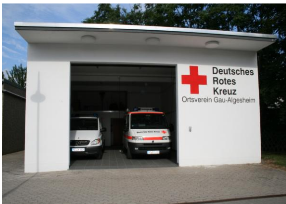
Bild 6: Die erweiterte Fahrzeuggarage in der Wüstenrotstraße [Frontansicht] 34
