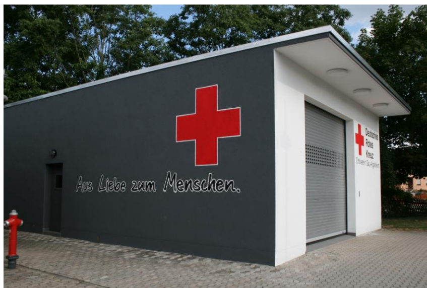
Bild 7: Die erweiterte Fahrzeuggarage in der Wüstenrotstraße [Seitenansicht mit Motto] 37
