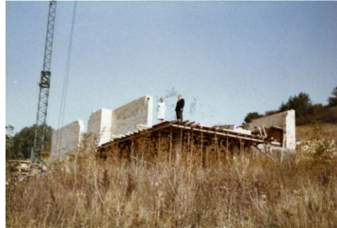
Bauarbeiten am Haus der Familie Wirtz 1971
