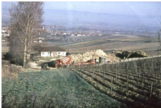
Das zweite Haus wird gebaut
