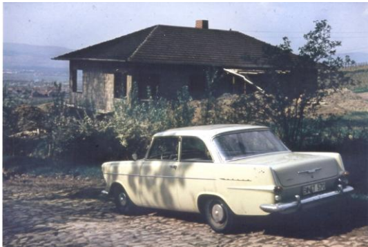
Rohbau des ersten Hauses auf der linken Straßenseite (Richtung Kloster)
