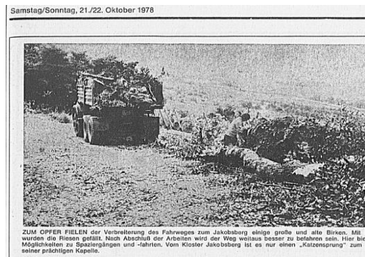
Strassenbauarbeiten 1978. Die Steigungen werden moderater gestaltet und es erfolgt eine Teerdecke bis zum Kloster
