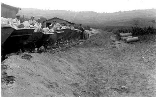
Mit Hilfe einer Bremsberganlage zogen die nach unten und mit Sandgefüllten Loren die steinebeladenen den Berg hinauf
