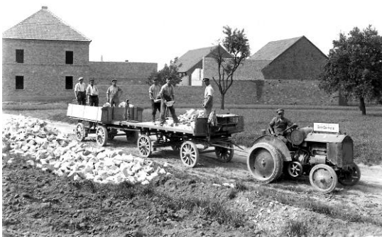
Die Steine wurden vom Ockenheimer Bahnhof zum Kuhweg gebracht. Ganz links Haus Weingut Bungert-Mauer
