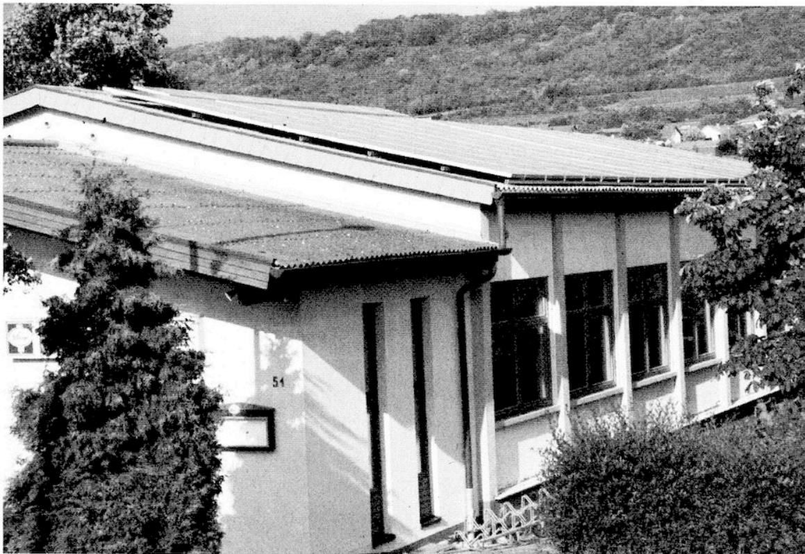
Radsporthalle mit Fotovoltaik-Anlage (Foto: Friedel Jouaux)
