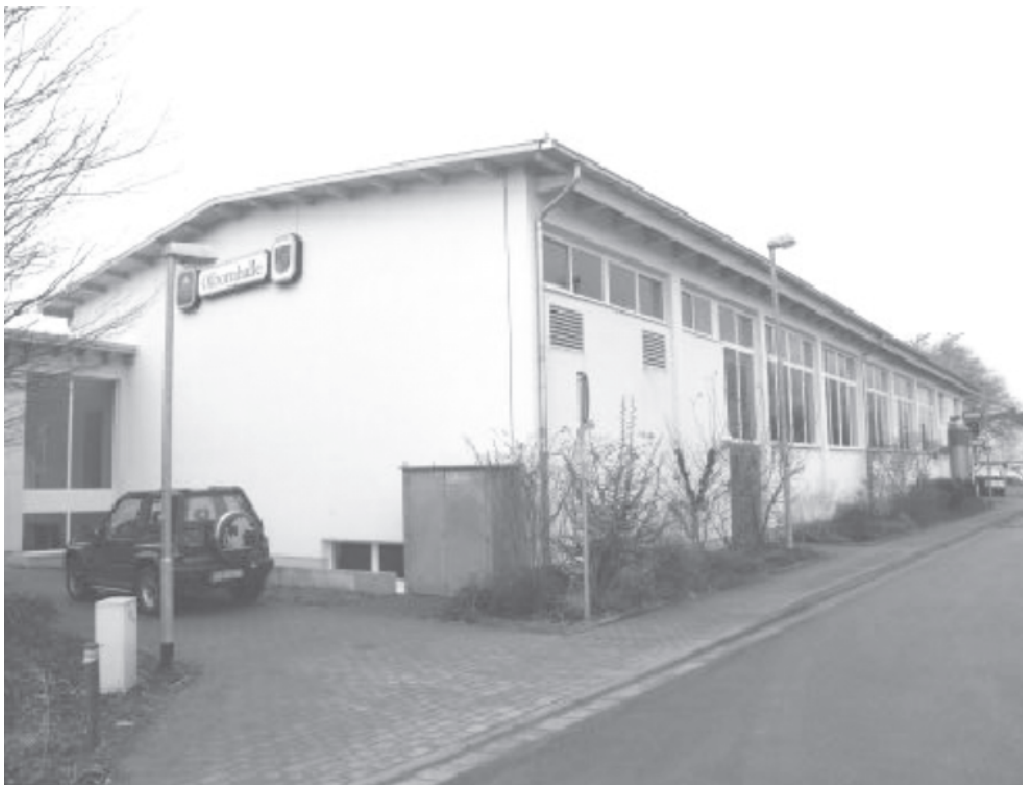
Abb. 4: Ein unscheinbares grünes Schalthäuschen an der Olbornhalle birgt die Regelanlage der Schwabenheimer Gasversorgung unweit des ehemaligen Gaswerks
