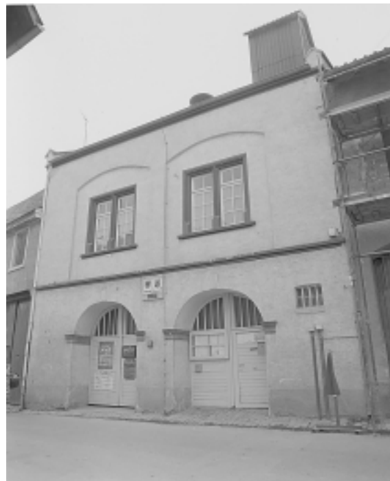
Auf der Aufnahme des Rathauses des Jahres 1976 ist der Schlauchtrockenturm noch erkennbar. Er wurde Anfang der 1990er Jahre bei der Renovierung des Hauses entfernt.
