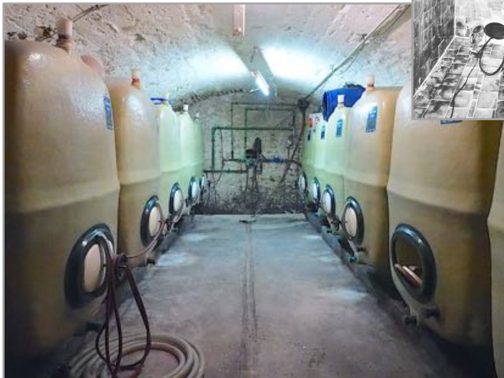
Der Keller eines ehemaligen Gau-Algesheimer Weinguts
